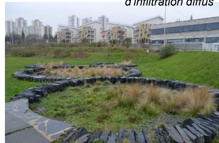
Exemples de dispositif de stockage et d'infiltration diffus
